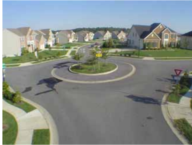
Stone Ridge Way/Windwood Road Mini Roundabout
