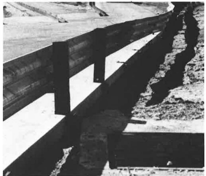
(d) W-3 thru W-5 post installation
