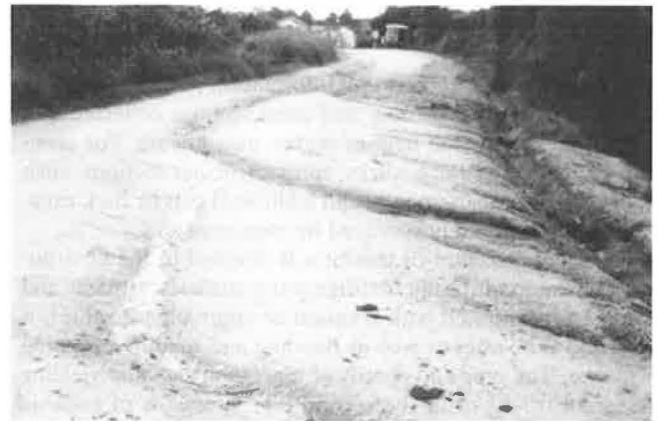
FIGURE 4 Longitudinal gullyng.
