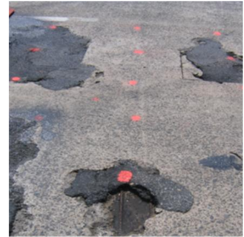
Spalling
