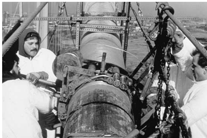
Figure 2.3.1.3.2.c-2. Manual wrapping machine.
