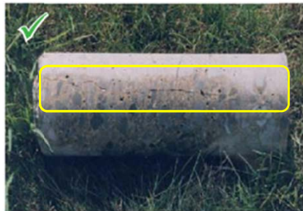
(d) Compliant core: Fine, full-depth vertical crack
