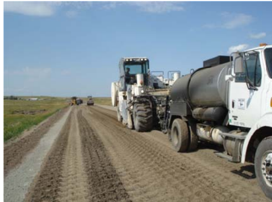
(d) FDR with foamed asphalt
