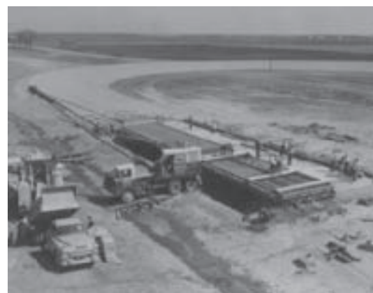
Pouring slab for test bridge.
