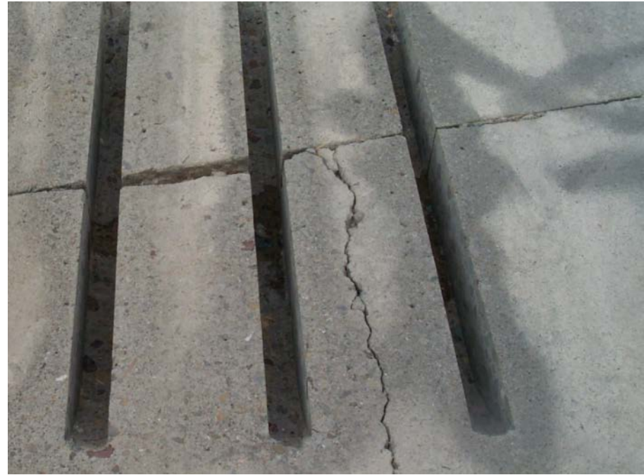
Avoid longitudinal cracks
