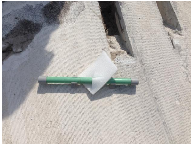
Dowel Bar Retrofit
