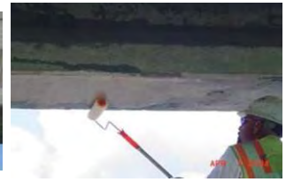
h) application of primer
