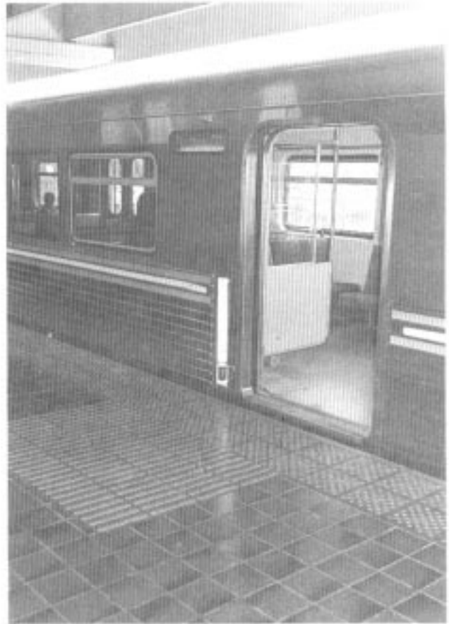
Figure 75. Metro-Dade Metrorail door positioning detectable tiles.
