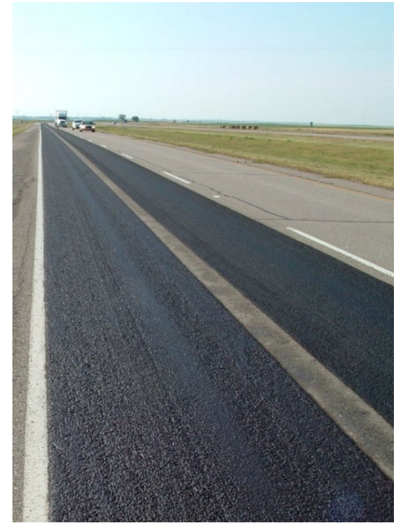
Micro surfacing rut fill (roadresource.org)
